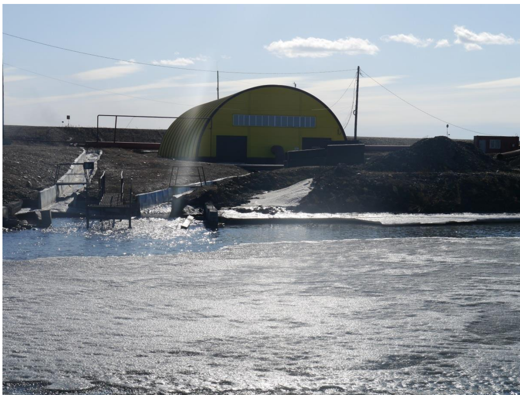
Очистные сооружения угольного разреза «Аршановский» (с. Аршаново, Алтайский район, 17.03.2020 г.)
